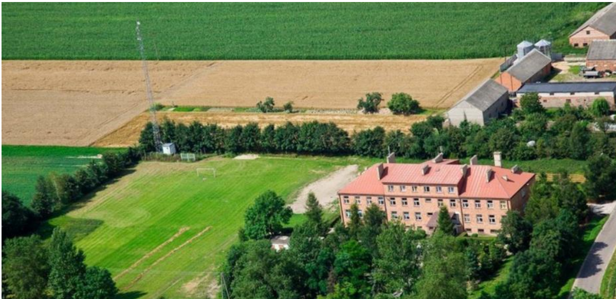
Zdjęcie 2 Zdjęcie budynku Szkoły Podstawowej w Szczycie
