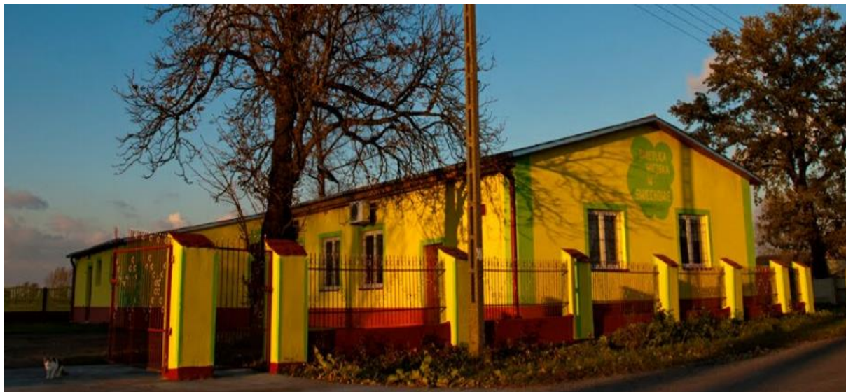
Zdjęcie 5 Świetlica wiejska w Świechowie
