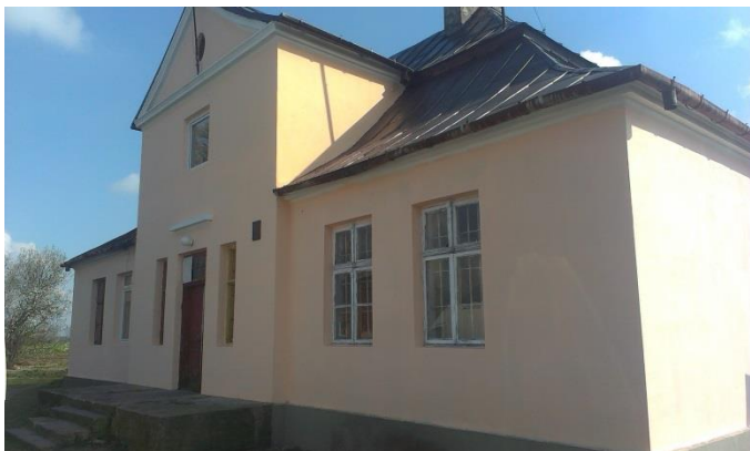
Budynek po remoncie
