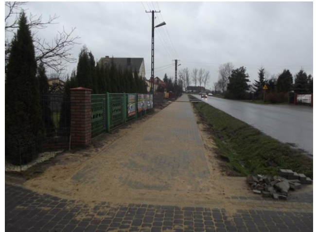
Budowa chodnika w Oporowie
