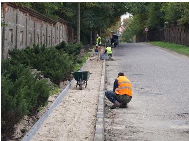
Prace przy budowie chodnika
