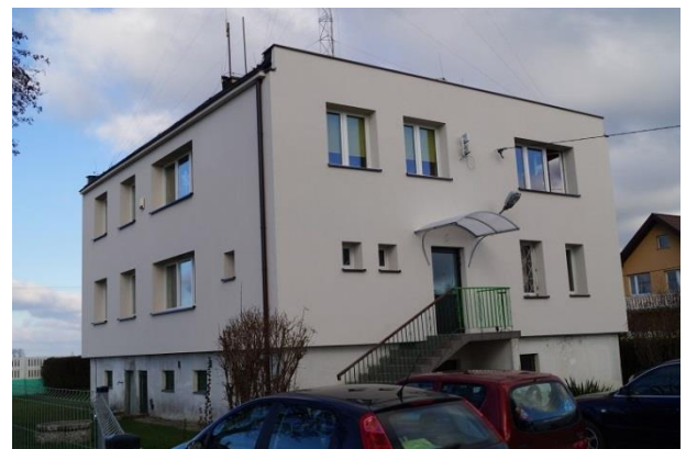
Budynek urzędu po termomodernizacji
