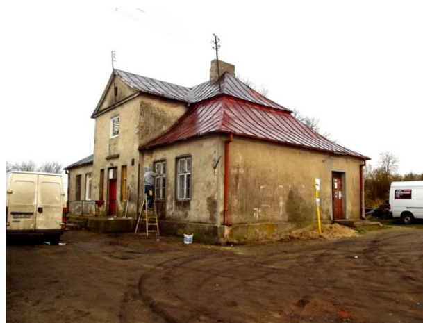
Budynek przed remontem
