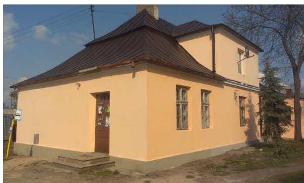
W trakcie remontu
